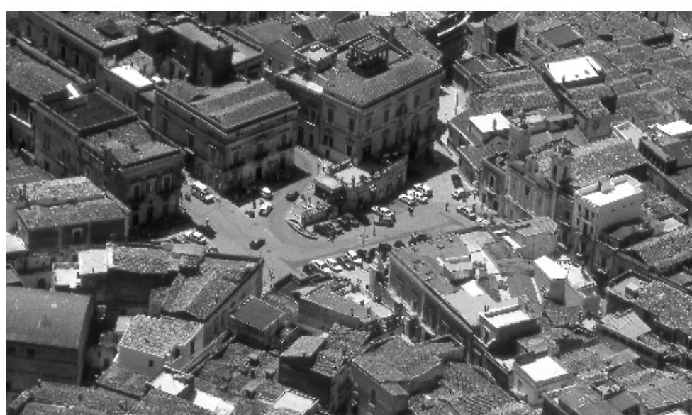
Una veduta aerea di piazza Bovio e del cinema comunale
